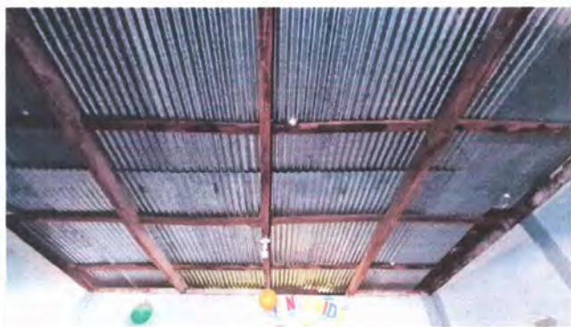
Foto1: Vista interior de módulo 2 de aulas, con intervención de remozamiento con sustitución de estructura de techo y lámina.
