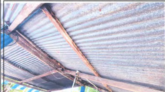
Foto 7: Vista interior de cocina, con intervención de remozamiento con suministro e instalación de estructura y cubierta de techo.
