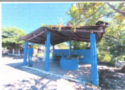
Foto 8: Vista exterior cocina con intervención en remozamiento con muro de block.
