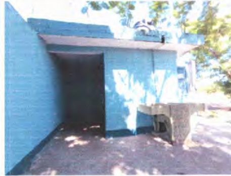
Foto 6: Vista exterior de servicios sanitarios, con intervención de remozamiento con aplicación de pintura.
