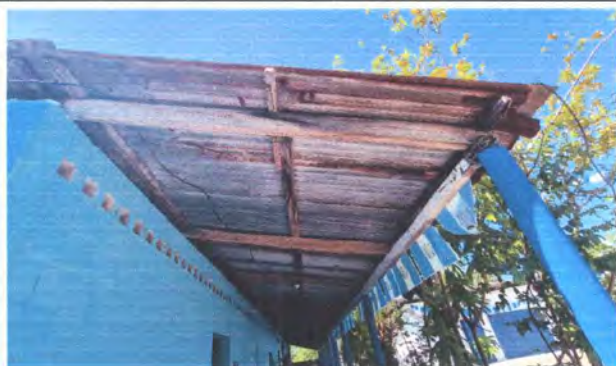
Foto 3: Vista exterior de módulo 2 de aulas, con intervención de remozamiento con sustitución de estructura de techo y lámina.
