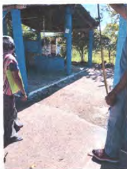
Foto 9: Vista área de cocina, con intervención de remozamiento con muro de block y piso.
