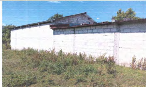
Foto 4: Vista exterior de módulo 1 y 2 de aulas, con intervención de remozamiento con muro de block con alza en altura, por el calor en aulas.
