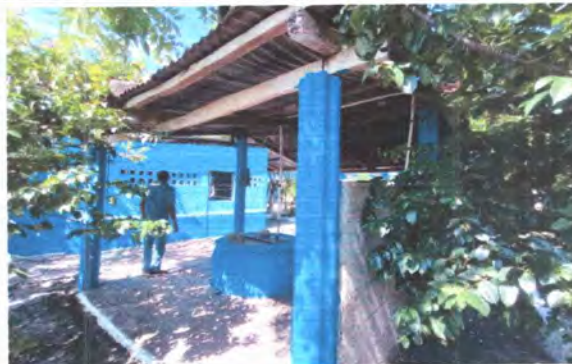
Foto 10: Vista exterior en cocina, con intervención de remozamiento con suministro de muro, balcón y puerta.
