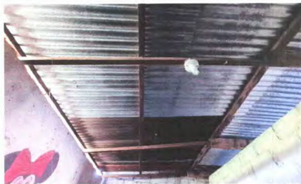
Foto 2: Vista interior de módulo 2 de aulas, con intervención de remozamiento con sustitución de estructura de techo y lámina.
